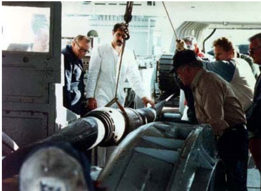
TAT-8 instalação do cabo
