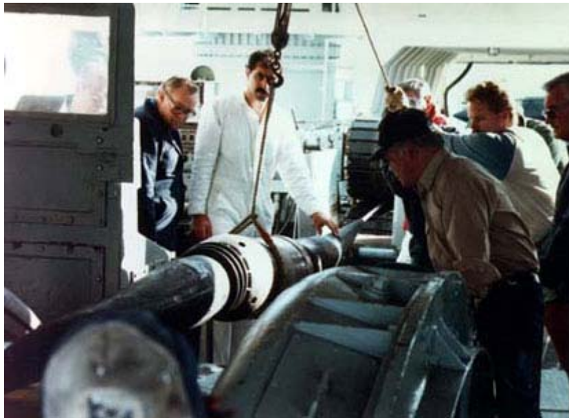
TAT-8 instalação do cabo
